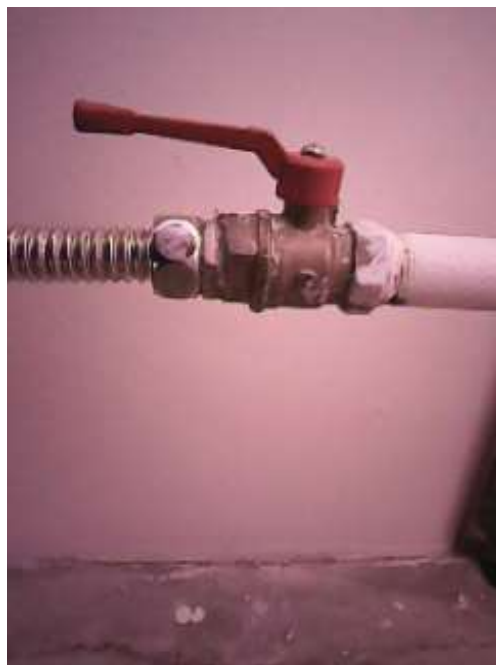
Рисунок 2 – Соединение нержавеющей сталь – латунь – окрашенная латунь – окрашенная сталь
