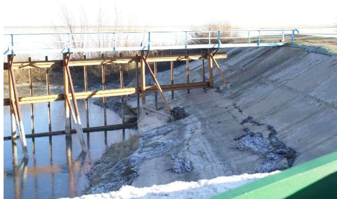
Рисунок 6 – Верхний бьеф, ледозащитное устройство
